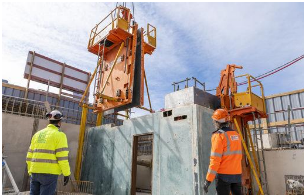
Test de coulage de béton très bas carbone
