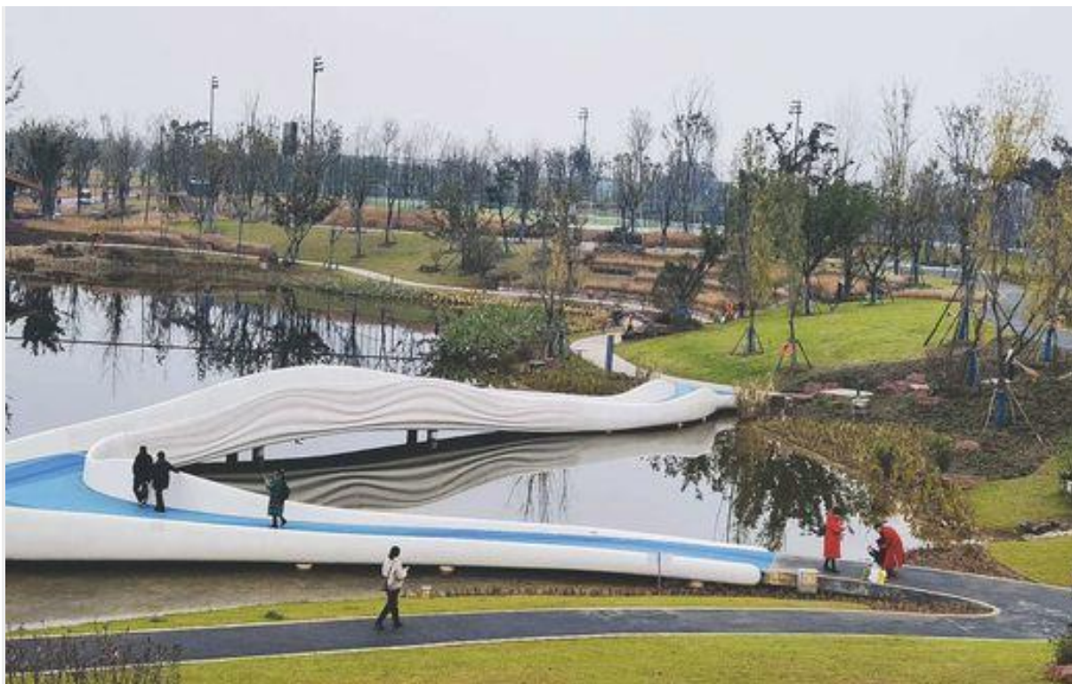
A Chengdu, un pont piéton en plastique de 22 m de long a été imprimé en septembre 2021. - - © PHOTOS : POLYMAKER / SCG
