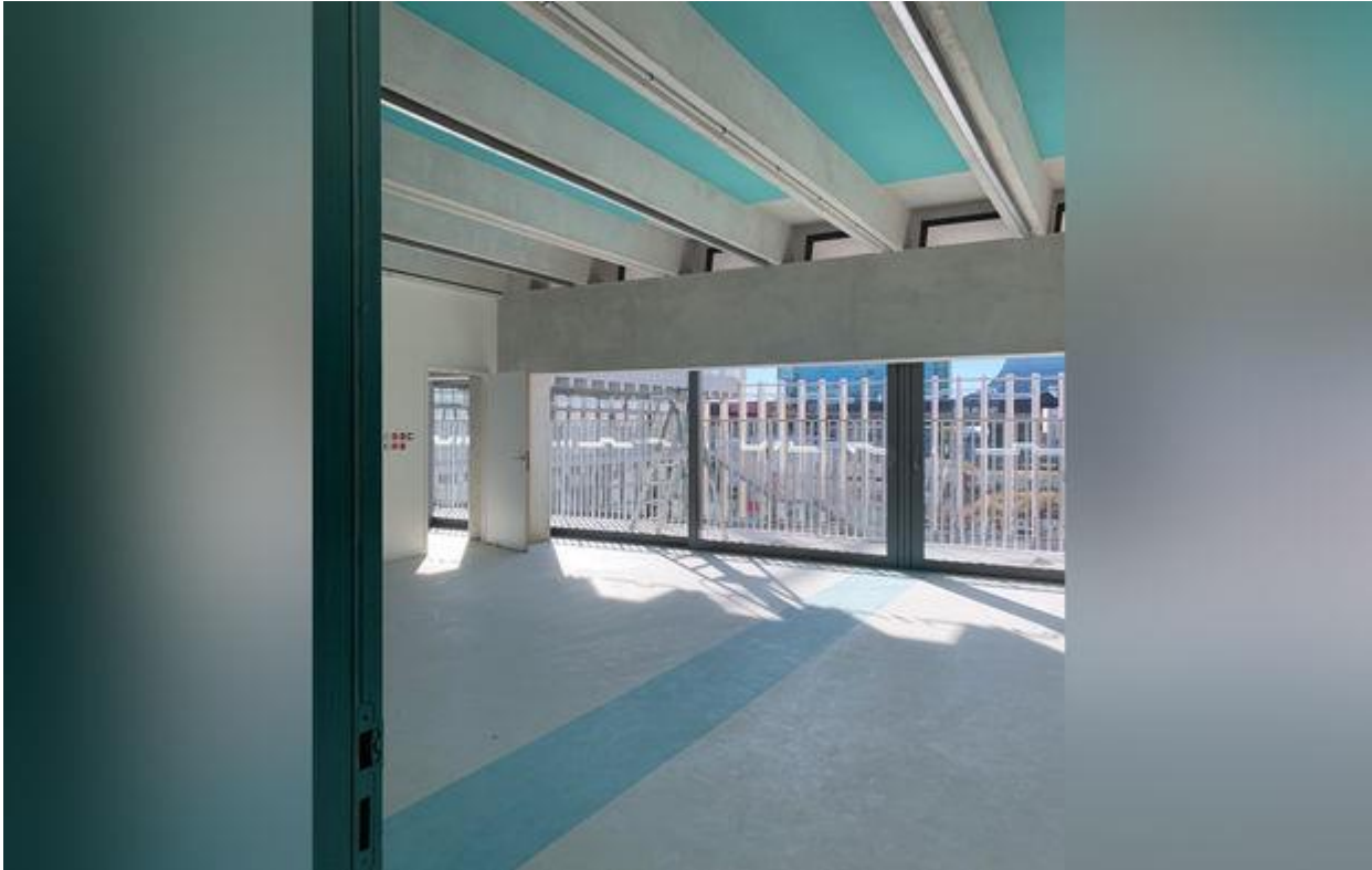
Intérieur d'une salle de classe élémentaire. Protégées par de larges casquettes, les façades des classes aux étages supérieures sont des murs à ossature bois en mélèze avec isolation intégrée.
