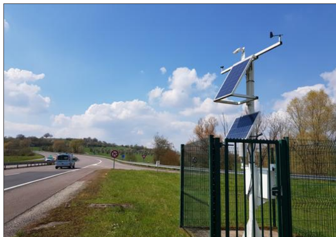
Les caméras installées sur la RD 31 bis, comme ici à Bousbach, ont pour but de visualiser le trafic sur la voie rapide : elles sont alimentées par panneaux solaires. Photo RL/Stéphane MAZZUCOTELLI
